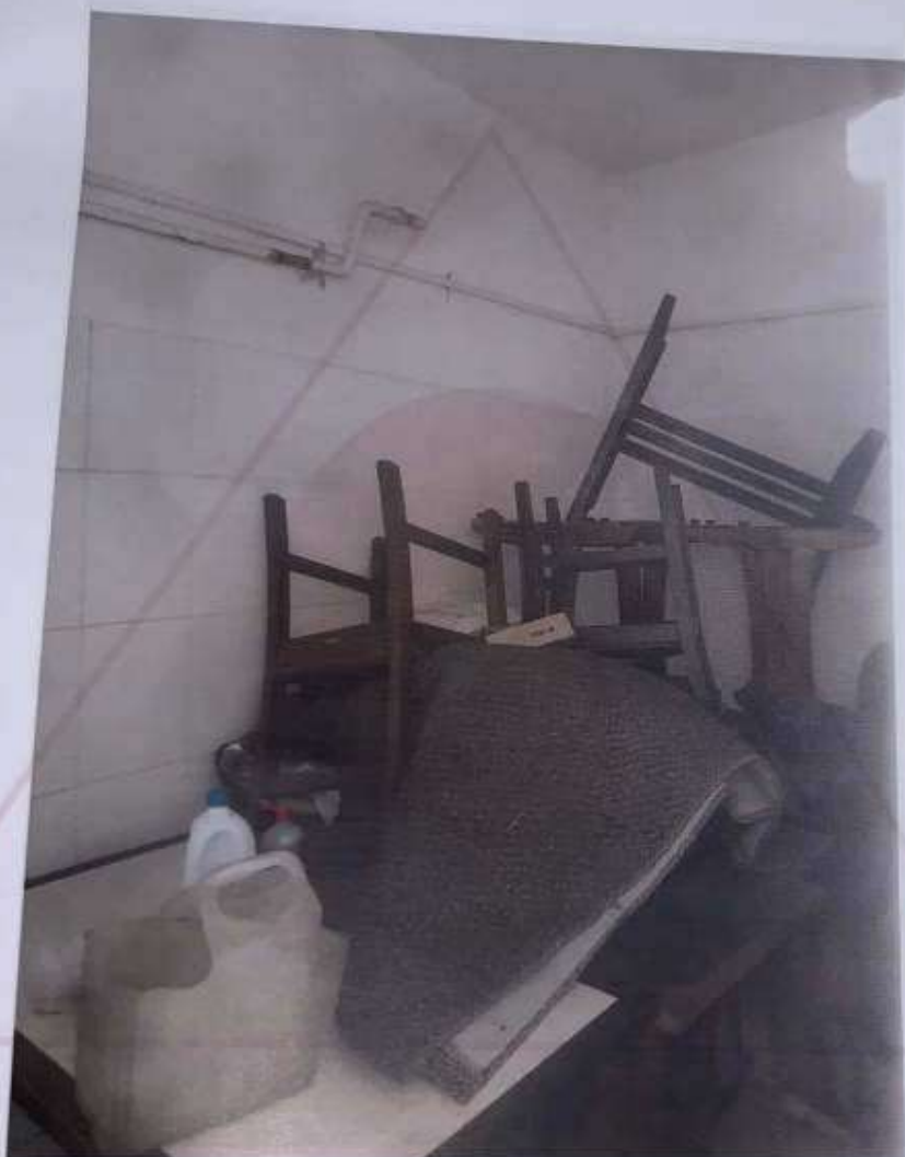
FOTO 50: VISTA GERAL SANITÁRIO.
