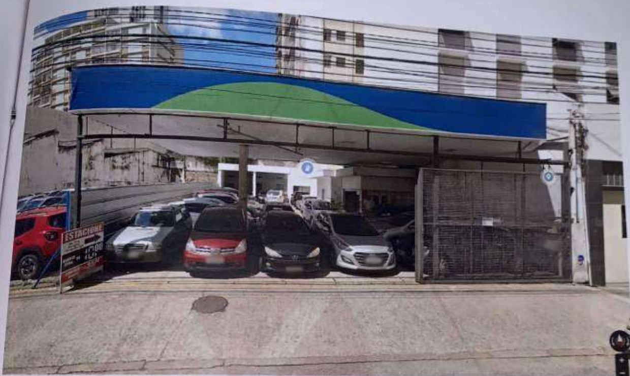
FOTO 37: VISTA GERAL DO IMÓVEL AVALIANDO EM QUESTÃO.
