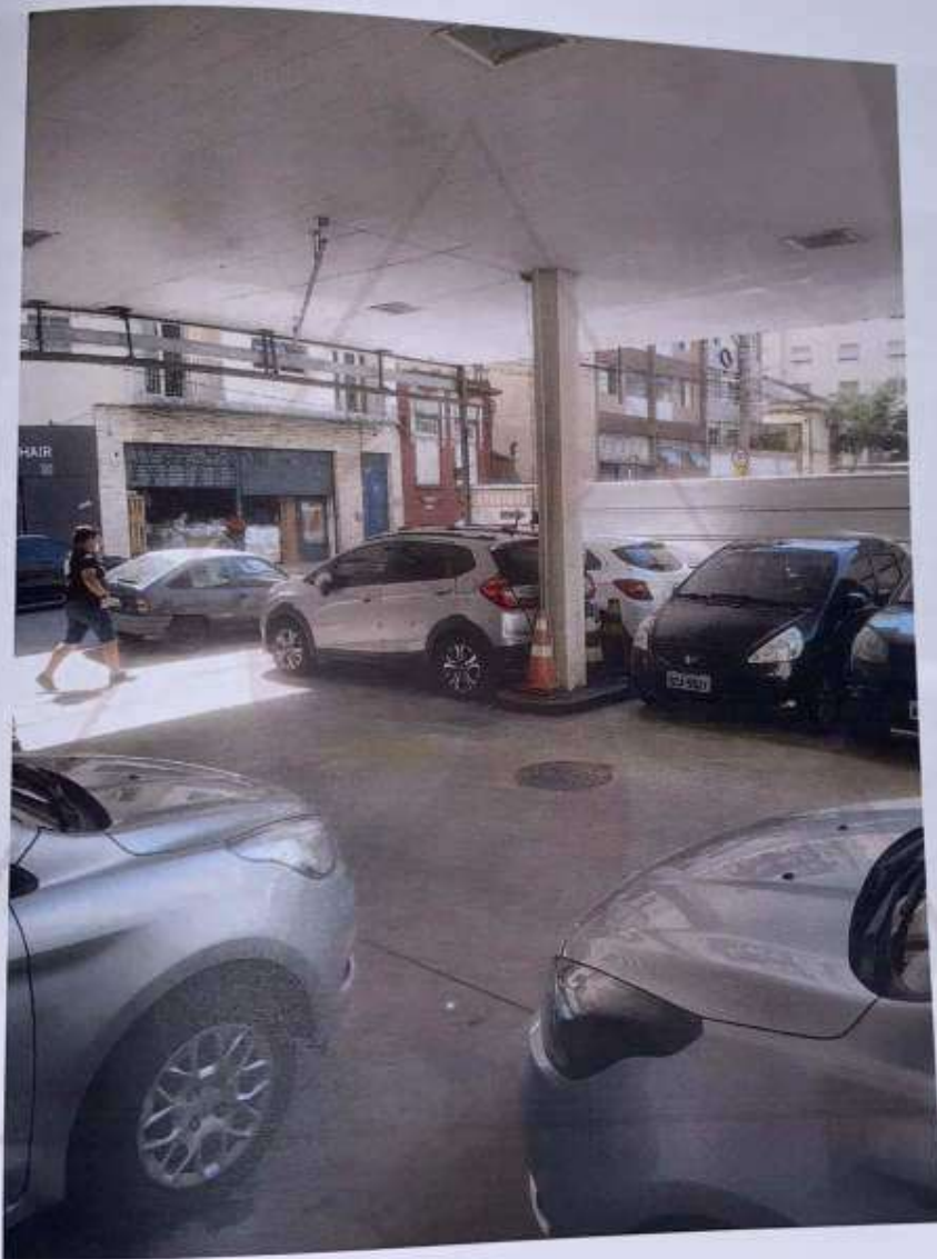
FOTO 40: VISTA DA ÁREA DA COBERTURA.
