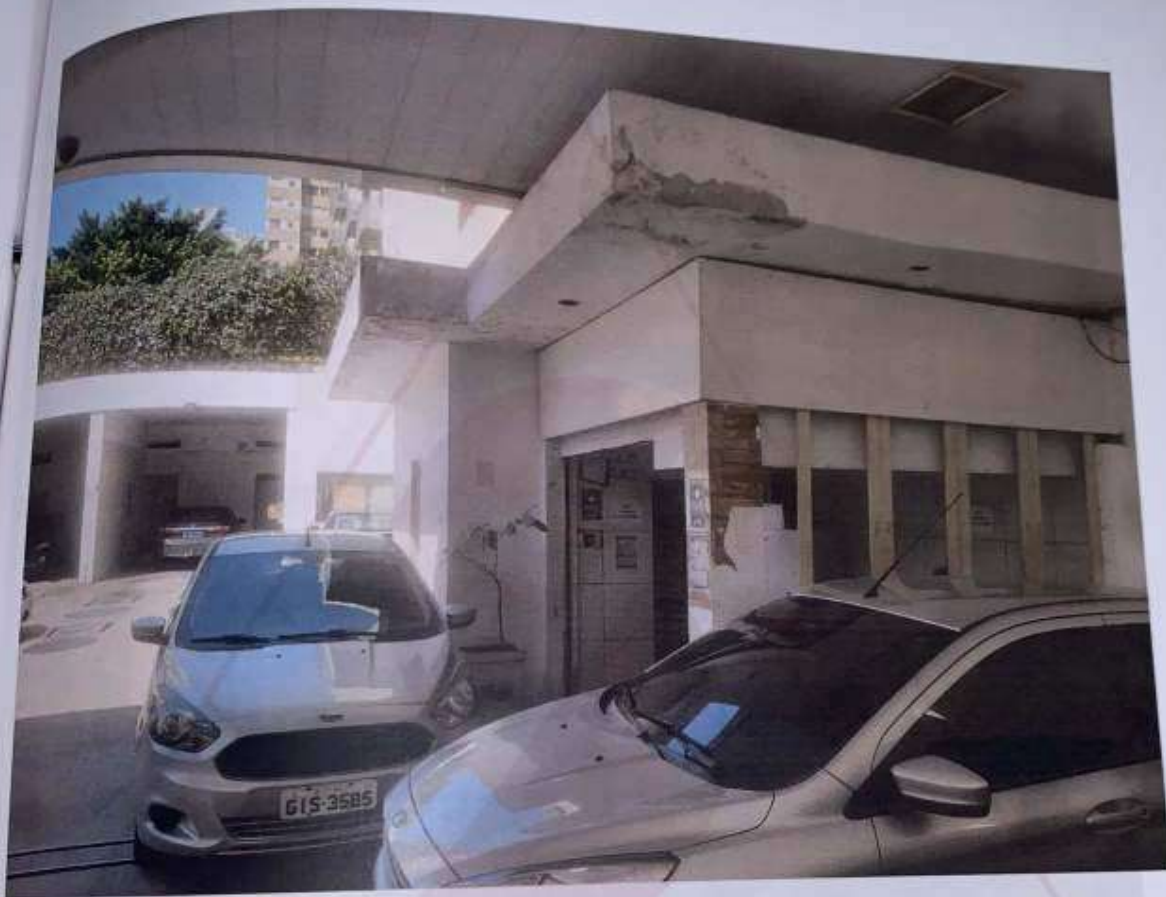
FOTO 42: VISTA PARCIAL DA EDIFICAÇÃO.
