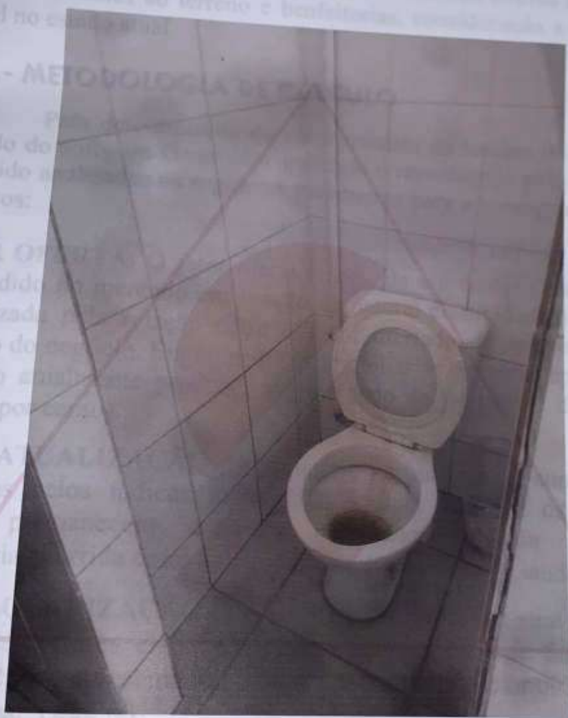
FOTO 51: OUTRA VISTA DO SANITÁRIO.
