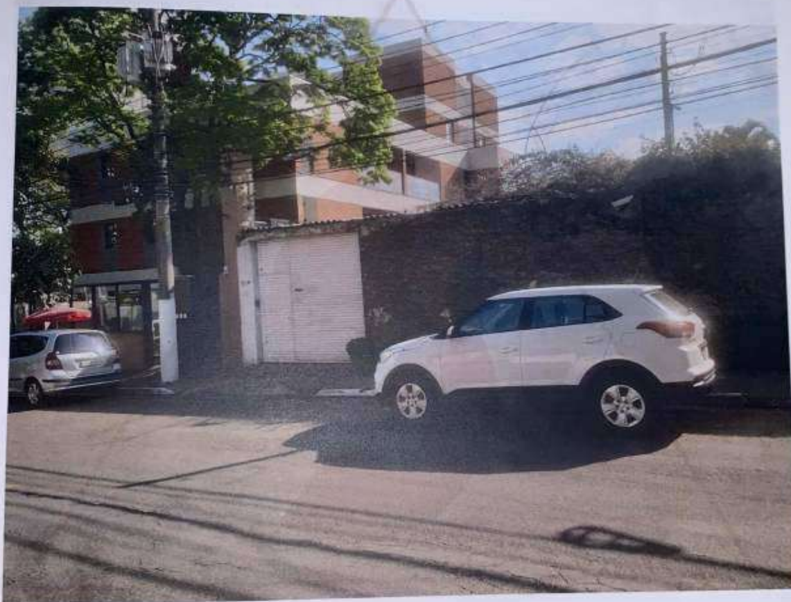
FOTO 6: VISTA GERAL DO IMÓVEL AVALIANDO.
