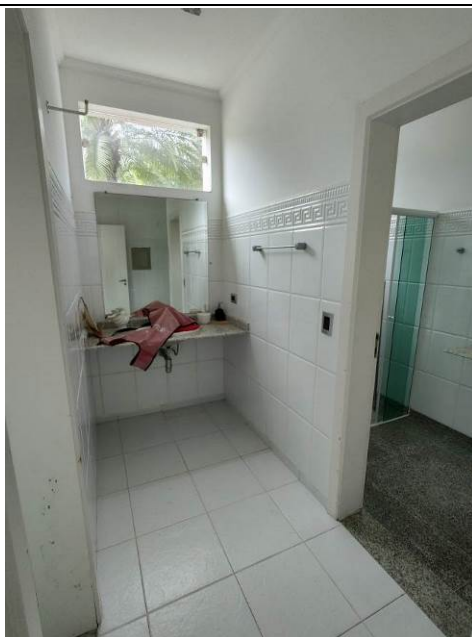
Foto 40: Área do lavatório da sauna
