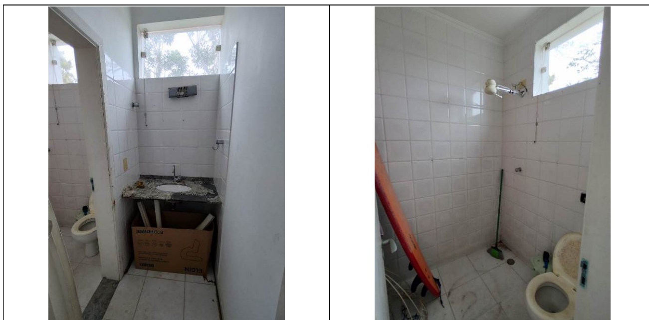
Fotos 33 e 34: Banheiro da casa de caseiro
