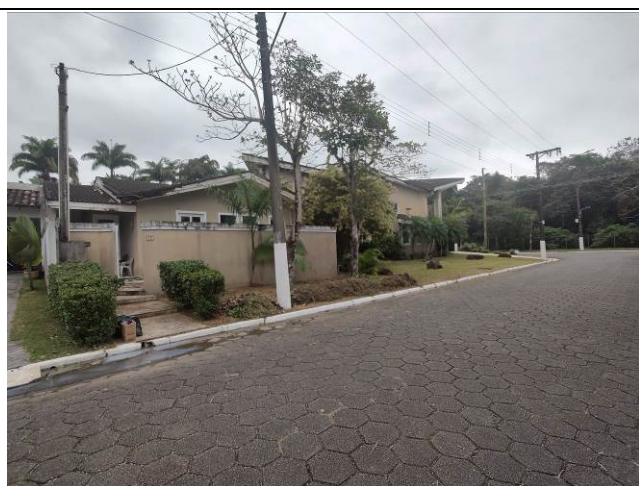
Foto 4: Fachada voltada para a Avenida Milton Mussa Gaze
