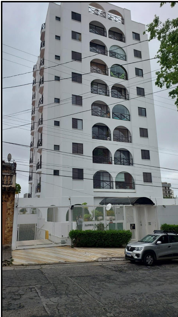
ASPECTO FRONTAL DO EDIFÍCIO ILLUMINATI
