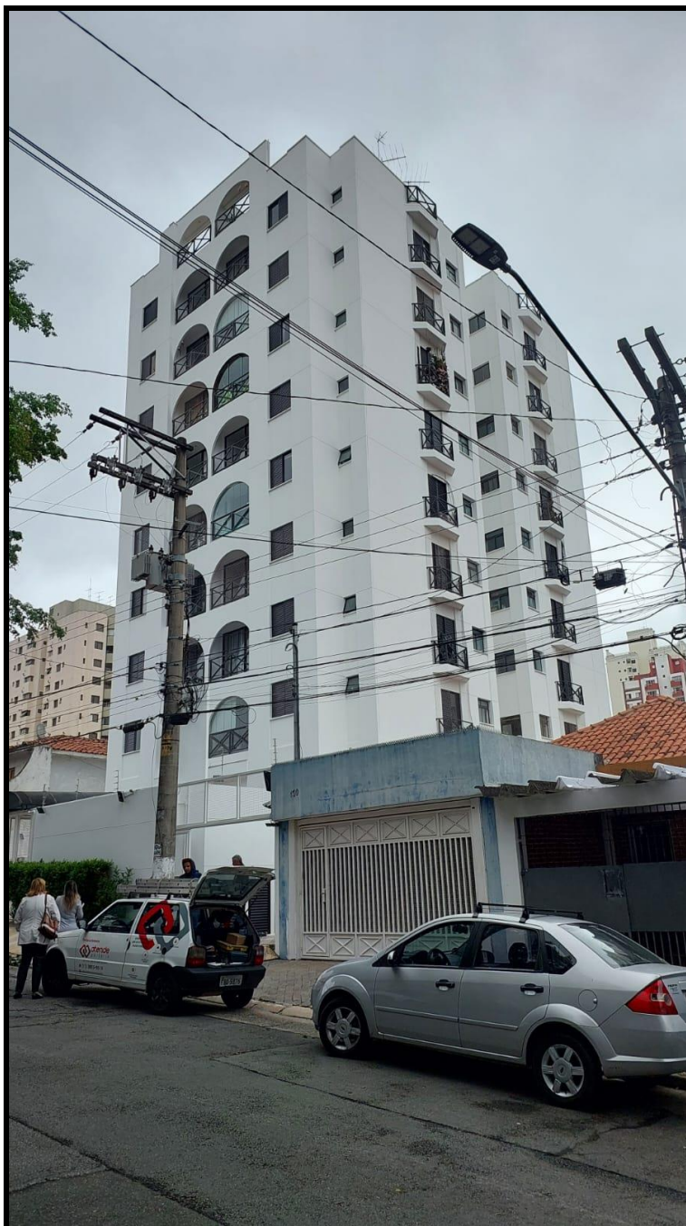
ASPECTO FRONTAL DO EDIFÍCIO ILLUMINATI
