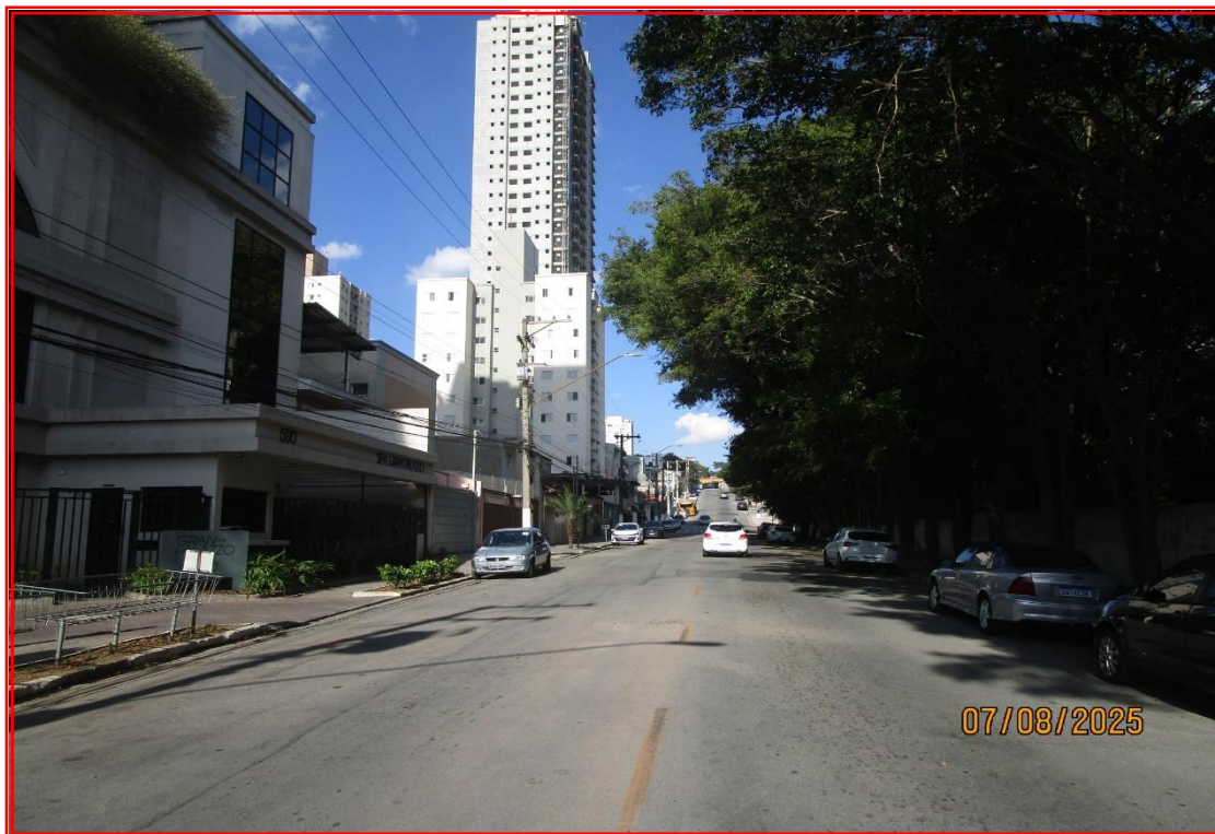
Foto: Vista parcial da Avenida Lunaninho Melli, no trecho onde se localiza o Condomínio Spa Gran Palazzo e respectivo imóvel avaliando.
