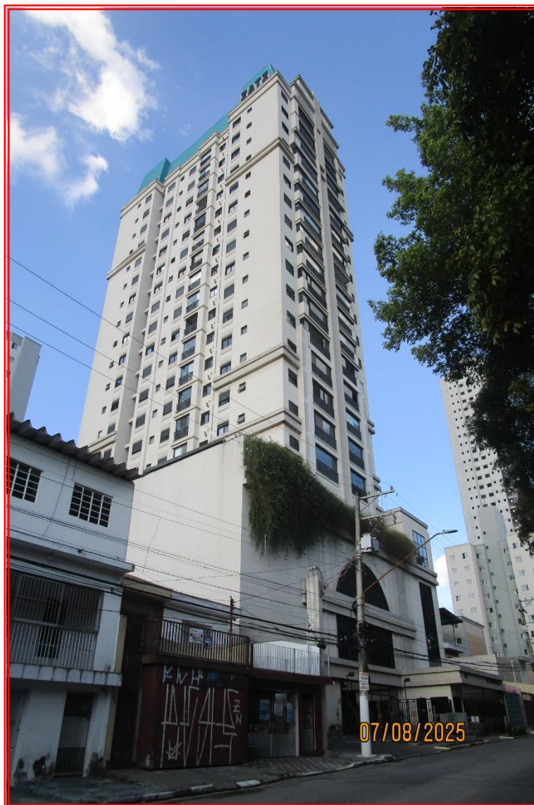
Foto nº 02: Vista geral da fachada do Condomínio Spa Gran Pallazo, tomada de outro ângulo.
