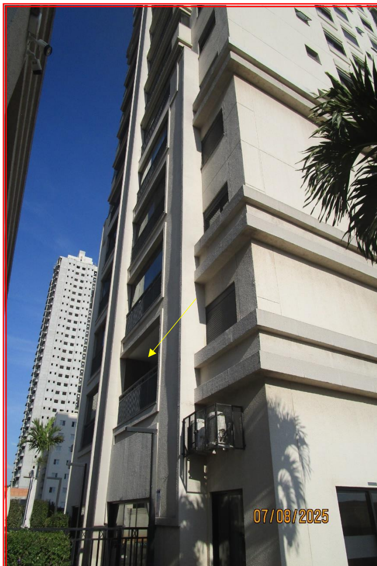
Foto nº 12: Vista parcial da fachada de fundos, com detalhe para a varanda do apartamento avaliando.
