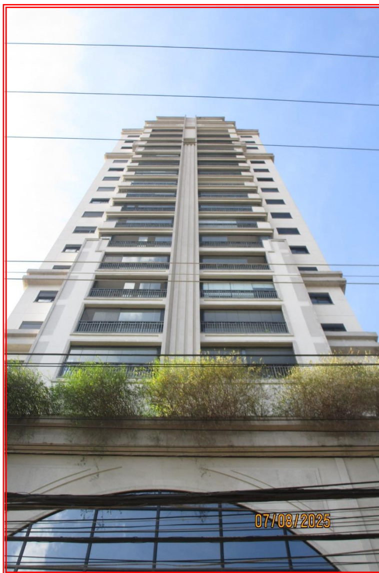
Foto nº 03: Vista geral da Fachada frontal, com detalhe para o estilo arquitetônico contemporâneo.
