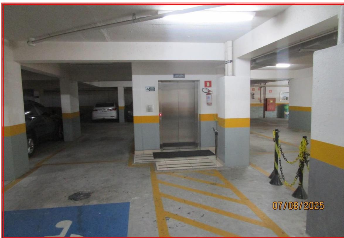
Foto nº 35: Vista parcial do hall de elevador do 1º sobressolo.
