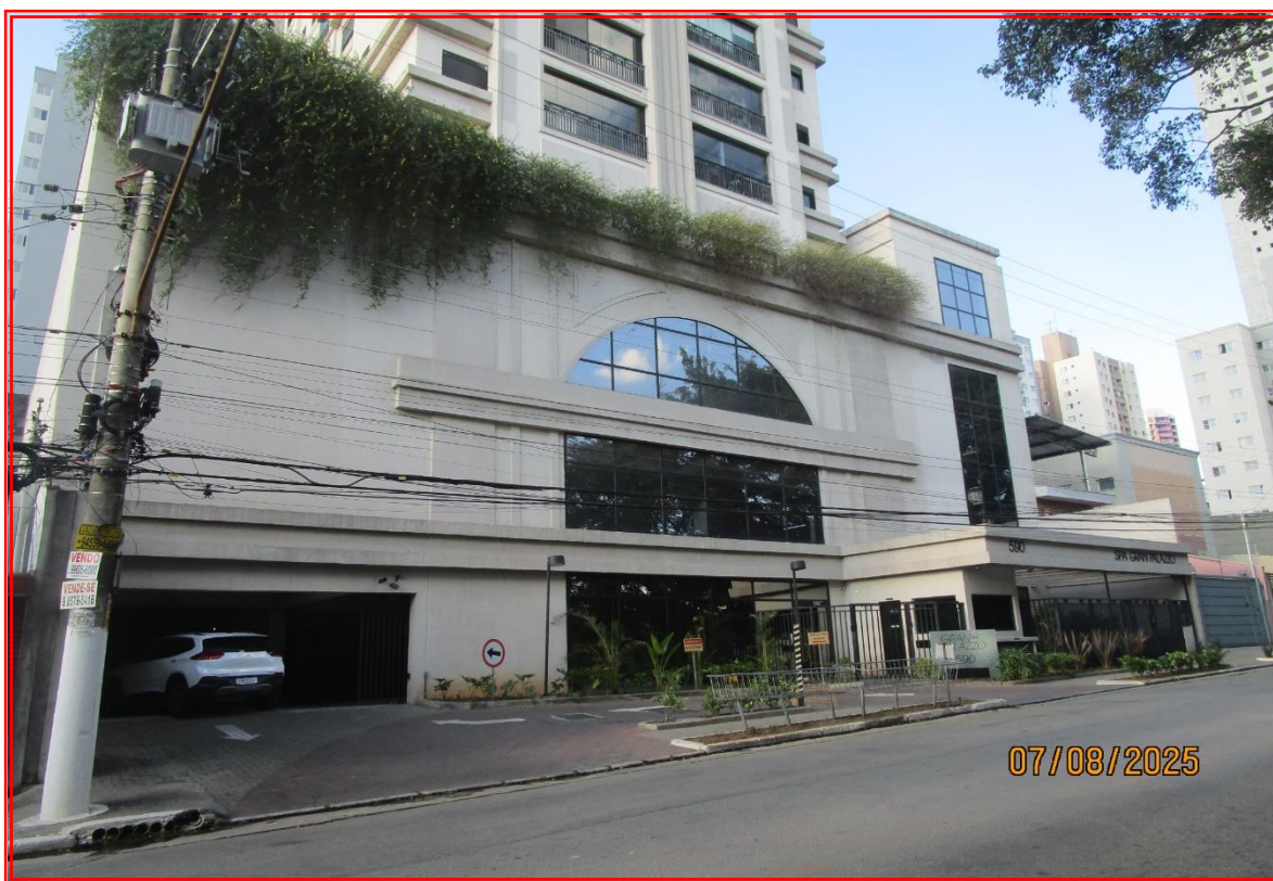
Foto nº 04: Vista geral do acesso a estacionamento e portaria.
