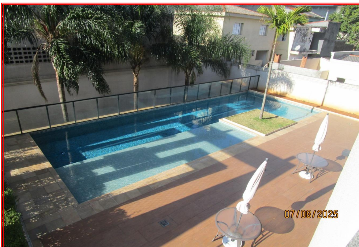
Foto nº 26: Vista parcial panorâmica das piscinas, com o observador posicionado na varanda.
