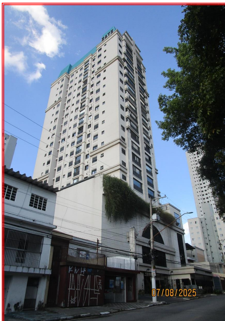
Foto: Vista geral do condomínio Spa Gran Palazzo, onde se localiza o imóvel avaliando.
