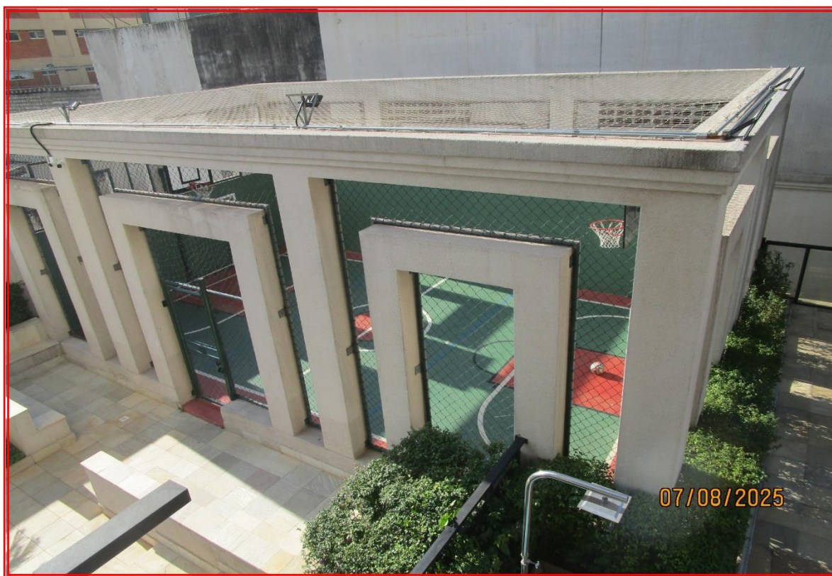
Foto nº 27: Vista parcial panorâmica da área de uso comum e quadra poliesportiva, com o observador posicionado na varanda.
