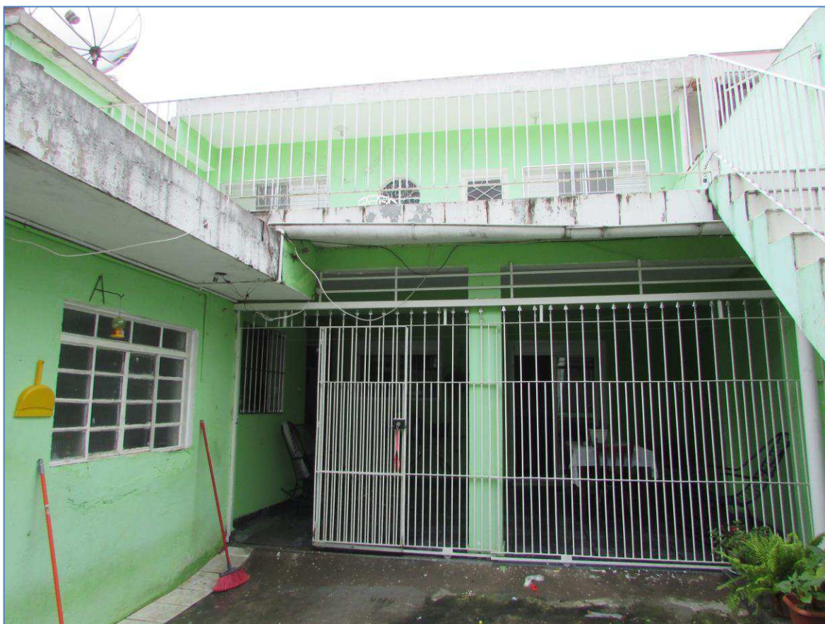
VISTA DA EDIFICAÇÃO.
