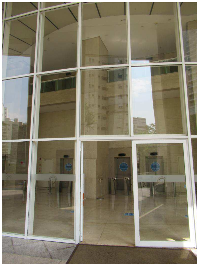
Foto nº. 5 – Vista da entrada do hall social.
