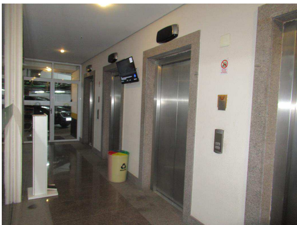
Foto nº. 13 – Vista dos elevadores do subsolo.
