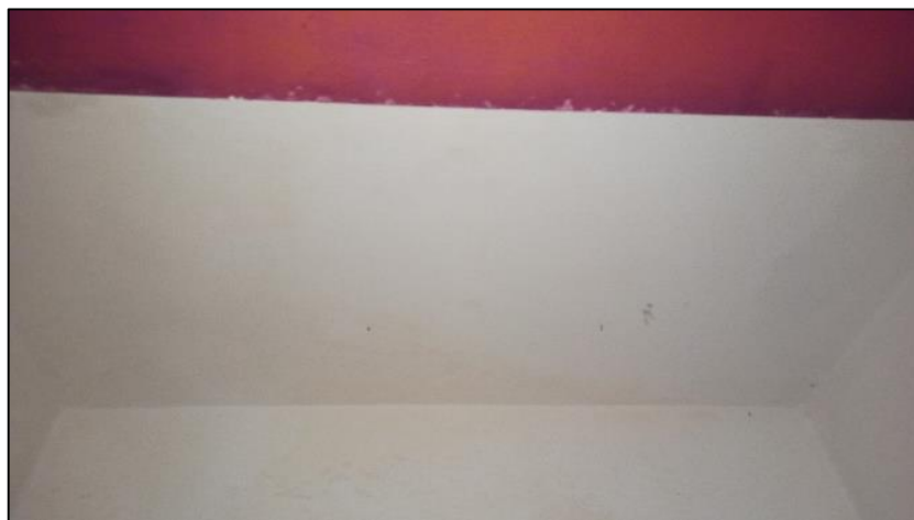
Foto 13. Vista do depósito
