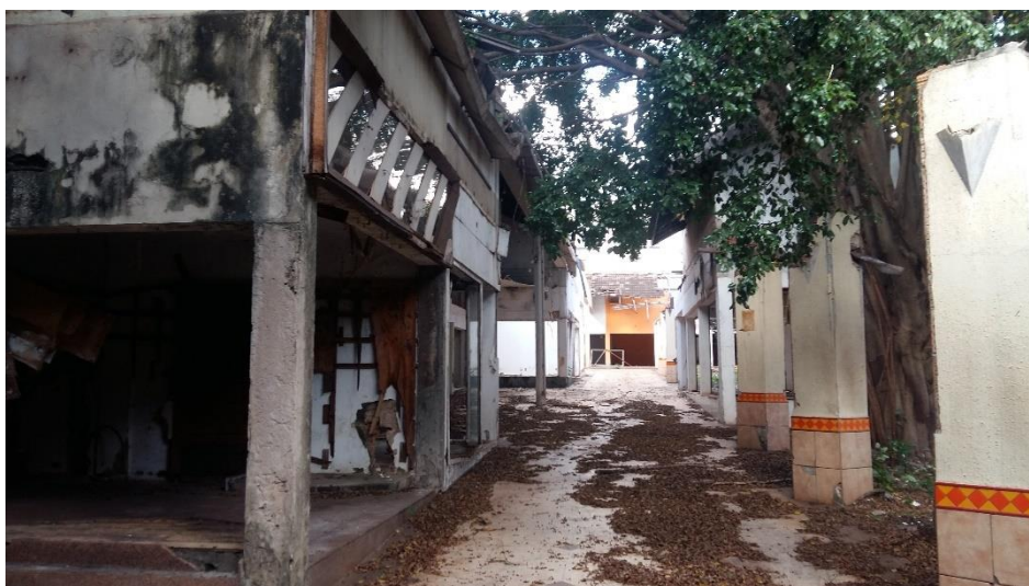
Foto 14 – Vista interna do shopping
