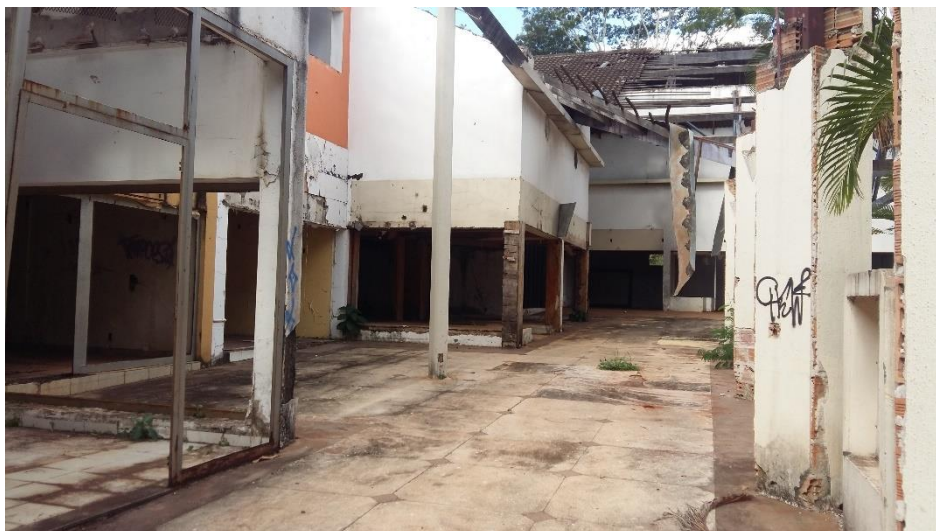
Foto 07 – Vista interna do shopping
