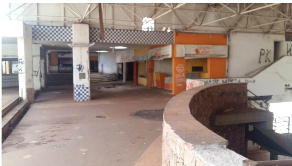
Foto 06 – Vista interna do shopping
