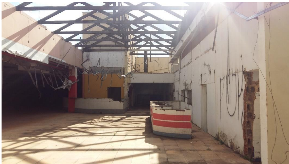
Foto 10 – Vista interna do shopping
