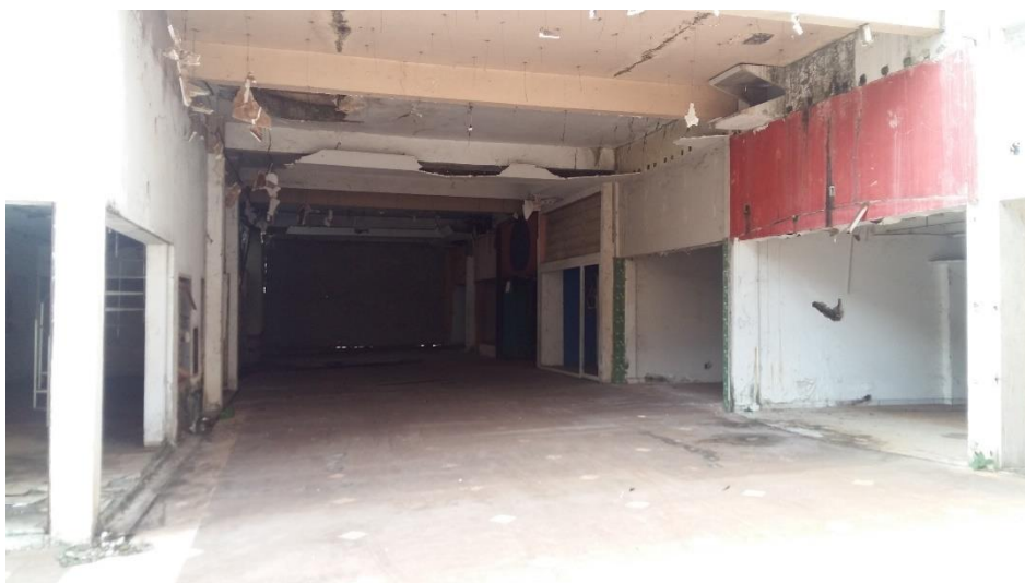
Foto 15 – Vista interna do shopping
