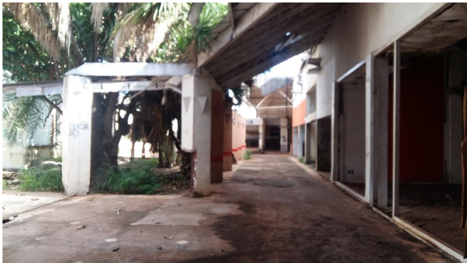
Foto 04 – Vista interna do shopping
