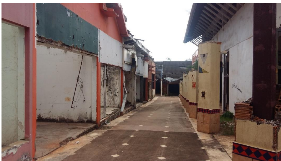
Foto 12 – Vista interna do shopping
