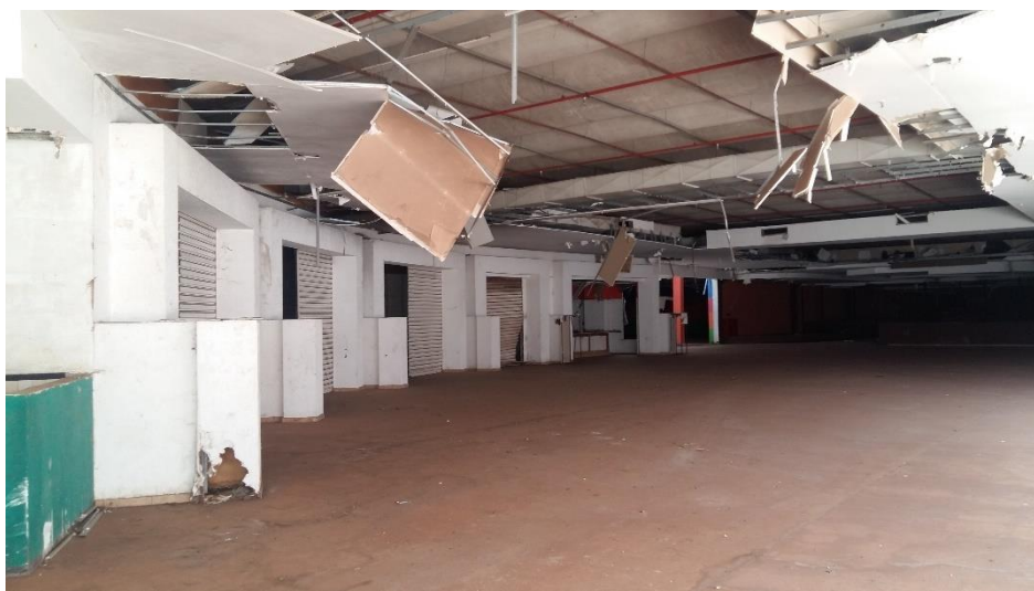
Foto 11 – Vista interna do shopping
