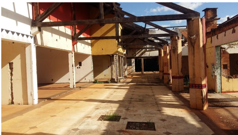
Foto 09 – Vista interna do shopping
