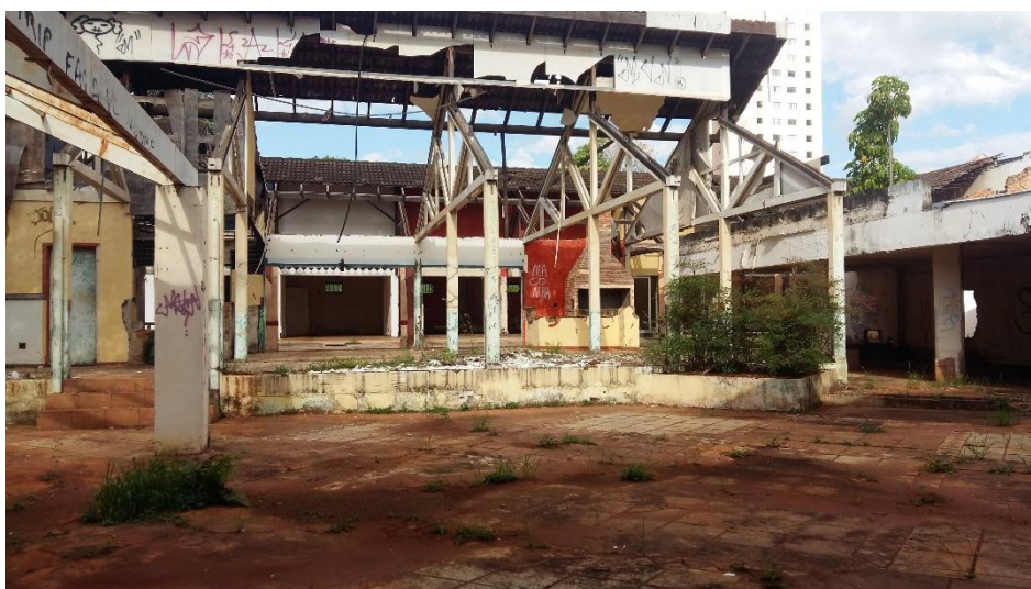
Foto 05 – Vista interna do shopping
