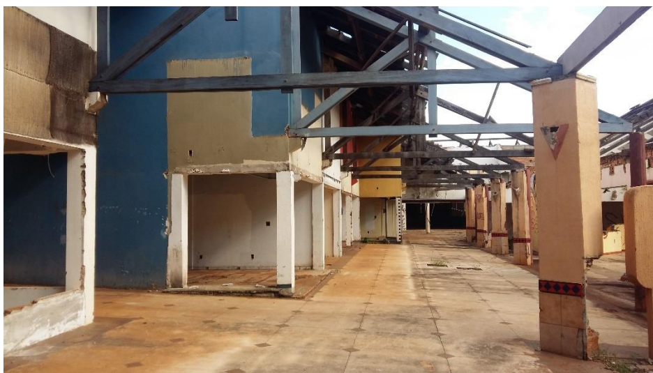
Foto 08 – Vista interna do shopping
