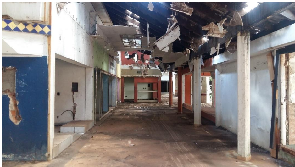
Foto 13 – Vista interna do shopping
