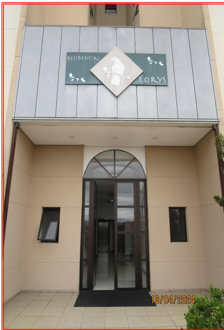
Foto nº 10: Vista do hall de entrada do pavimento térreo.
