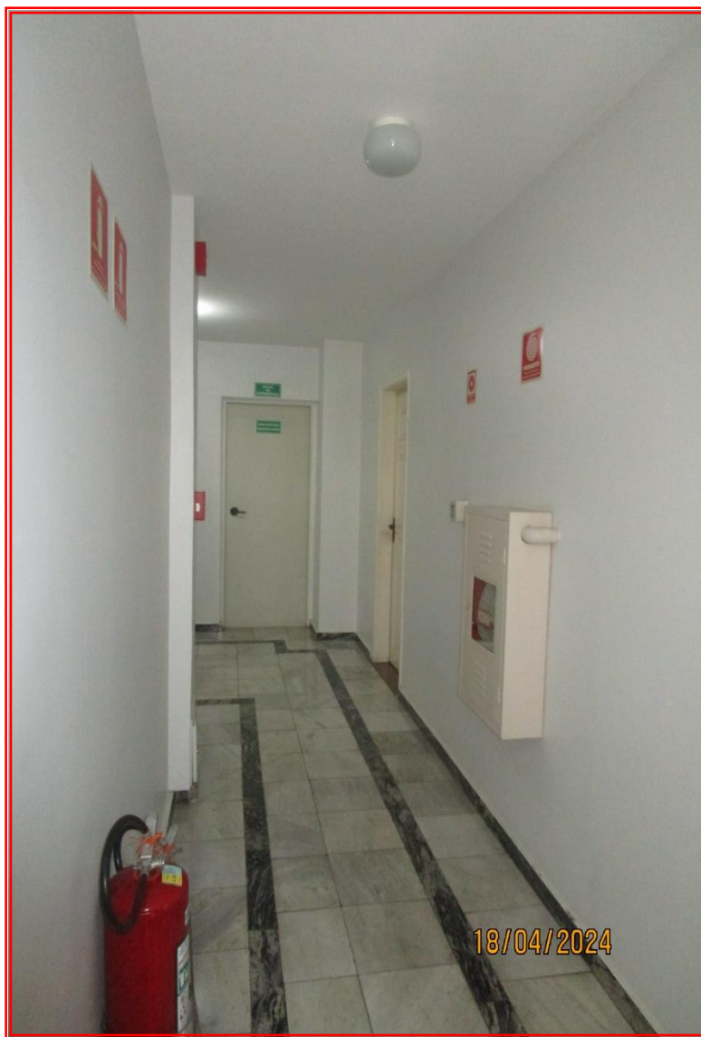
Foto nº 18: Vista parcial do hall do 10º andar, onde se localiza o imóvel avaliando.
