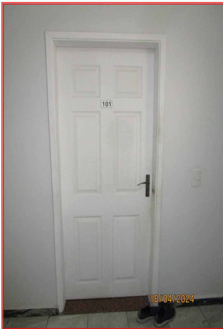
Foto nº 19: Vista geral da porta de entrada do apartamento nº 101, objeto da avaliação. Na data da vistoria a perícia não foi atendida.
