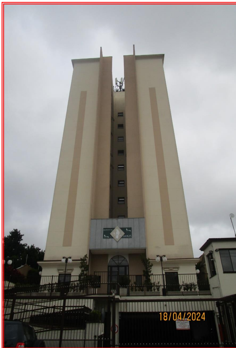
Foto nº 03: Vista frontal do Edifício “Lorys”, com detalhe para a portaria e identificação condominial.
