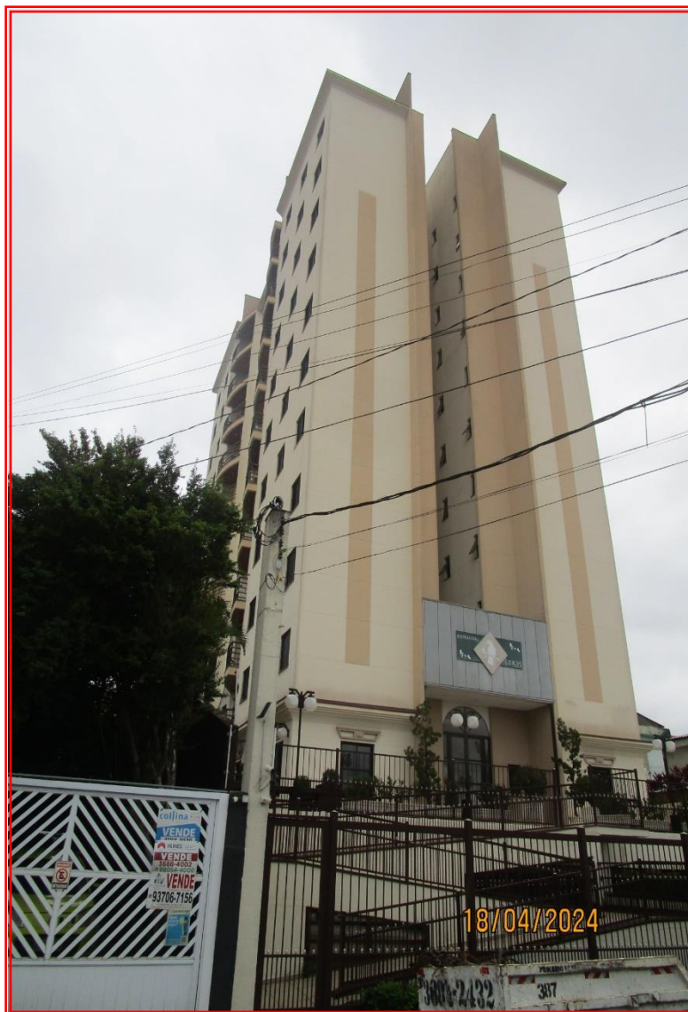
Foto nº 02: Vista geral do Edifício “Lorys”, tomada de outro ângulo.
