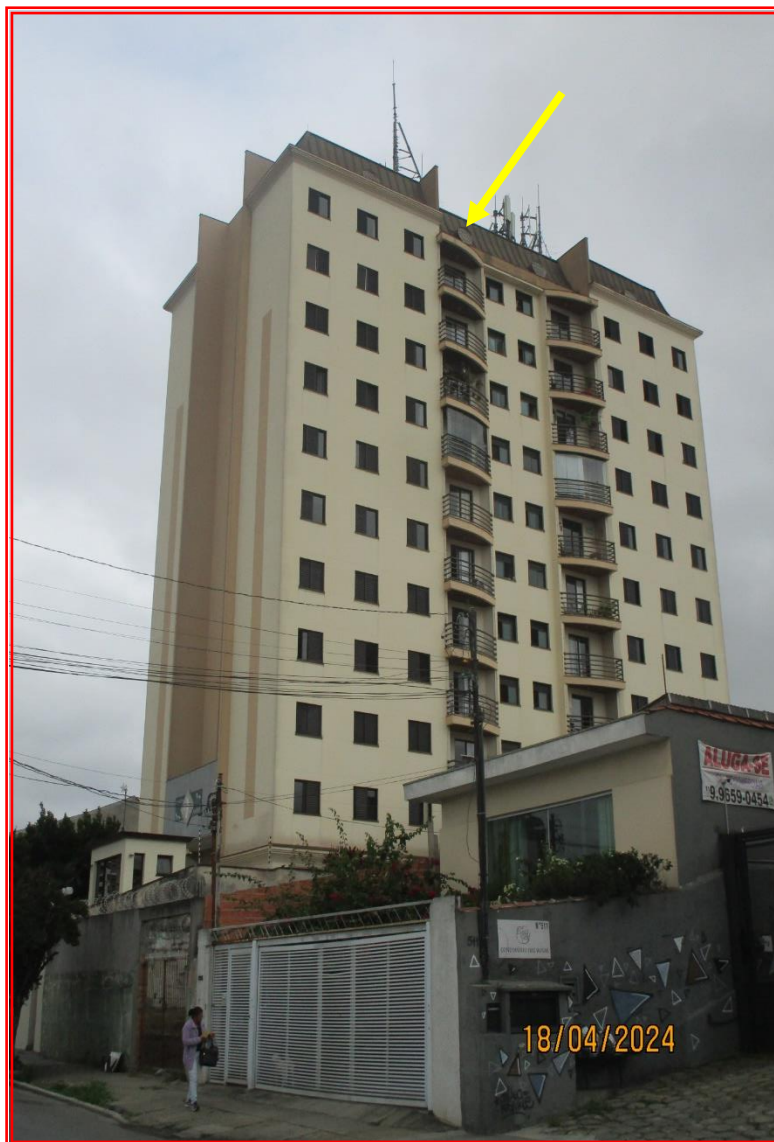
Foto nº 01: Vista geral do Edifício “Lorys”, onde se localiza o imóvel objeto da penhora e avaliação, composto pelo apartamento nº 101, localizado no 10º andar.
