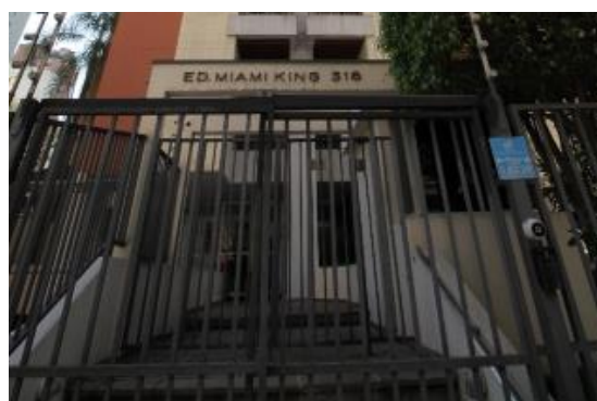
FOTO 15 – ENTRADA DO PRÉDIO
