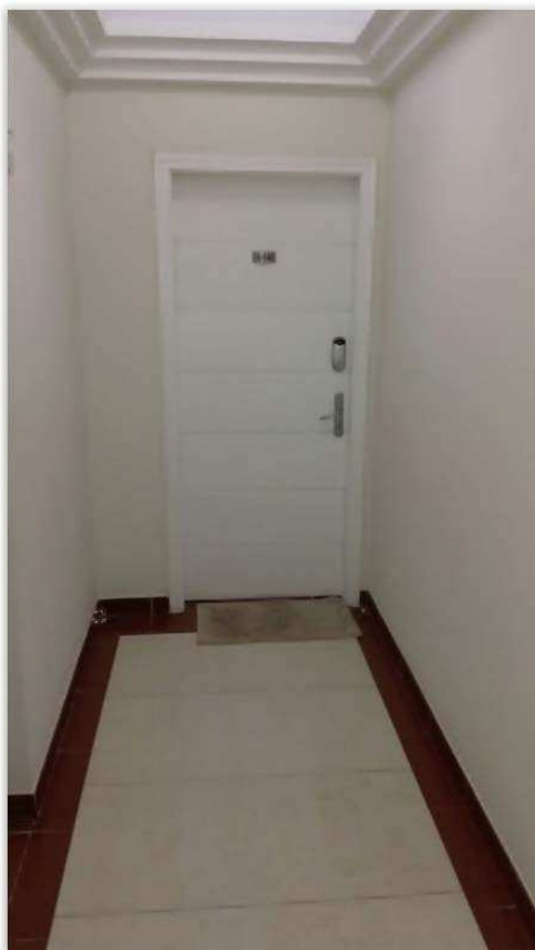
Foto 14 - Vista do hall de acesso ao imóvel avaliando.
