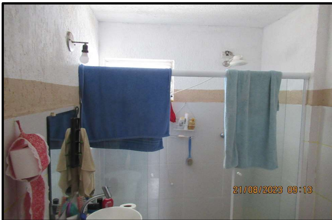
Foto nº 11: Vista do banheiro. Suas principais características construtivas são: piso cerâmico, paredes parte azulejadas e parte texturizada, forro em laje e esquadrias de alumínio.
