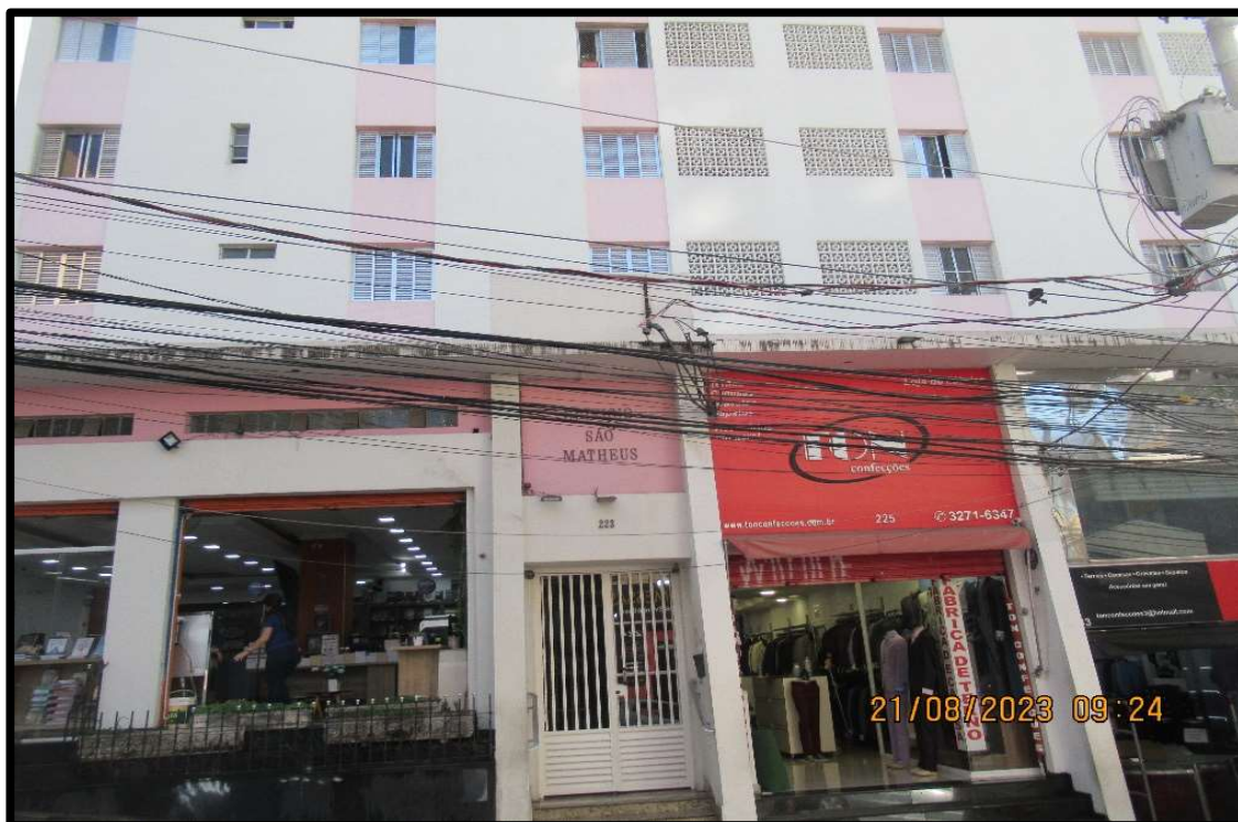
Foto nº 3: Vista da fachada do Edifício São Matheus onde se localiza a unidade em estudo, apartamento nº 42.
