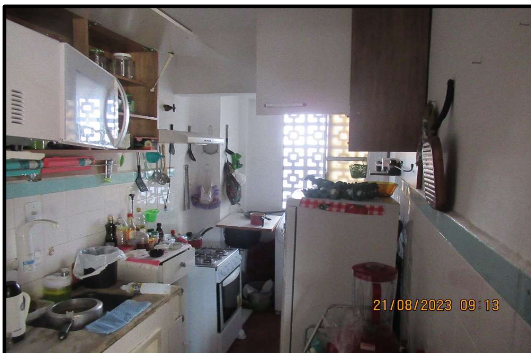
Foto nº 8: Vista da cozinha. Suas principais características construtivas são: piso cerâmico, paredes parte azulejadas e parte texturizada, forro em laje e esquadrias de alumínio.
