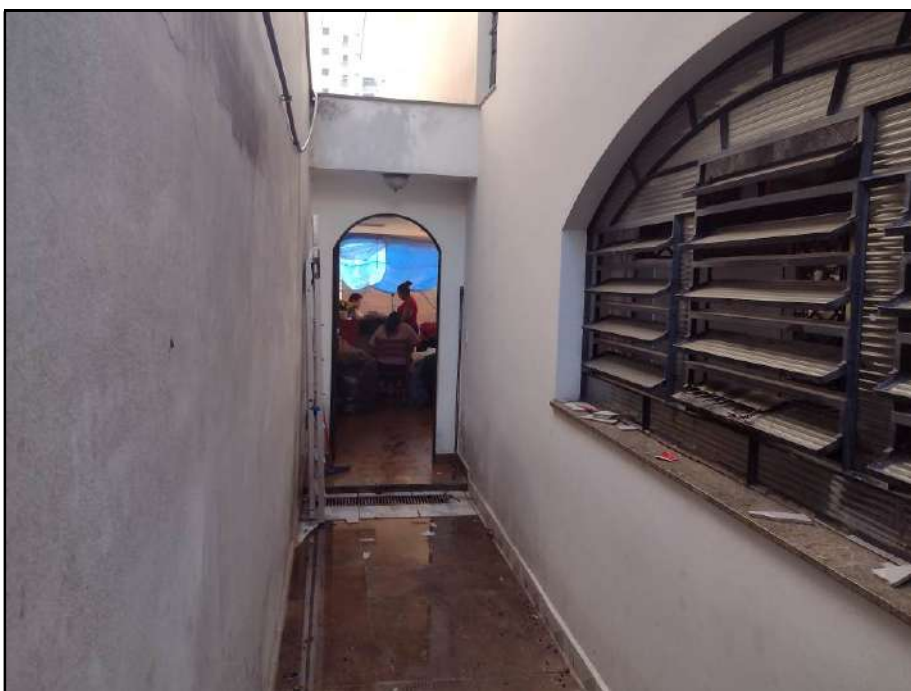
Vista do corredor externo.
