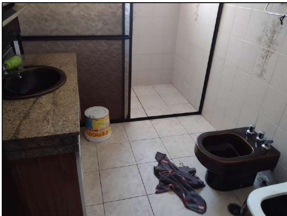
Vista do banheiro.
