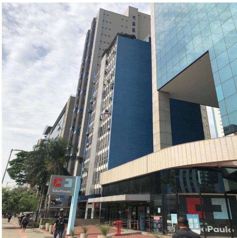
Vista das fachadas frontal e lateral esquerda do edifício Armando Shibata
